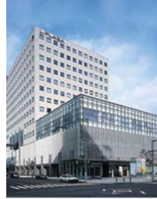
▶ 札幌エルプラザ
