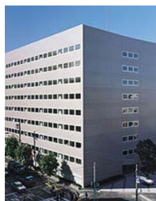
▶ NBF高輪ビル
