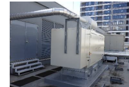
非常用発電機点検・更新 (NBF高輪ビル)
