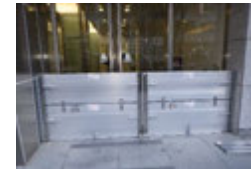
防潮設備の設置 (NBF東銀座スクエア)
