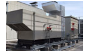
非常用発電機の増設 (NBF渋谷ガーデンフロント)
