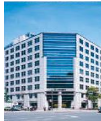
NBF虎ノ門ビル（建物部分）
