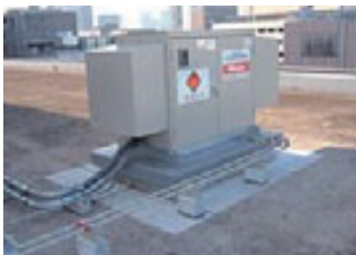
非常用発電機の整備
