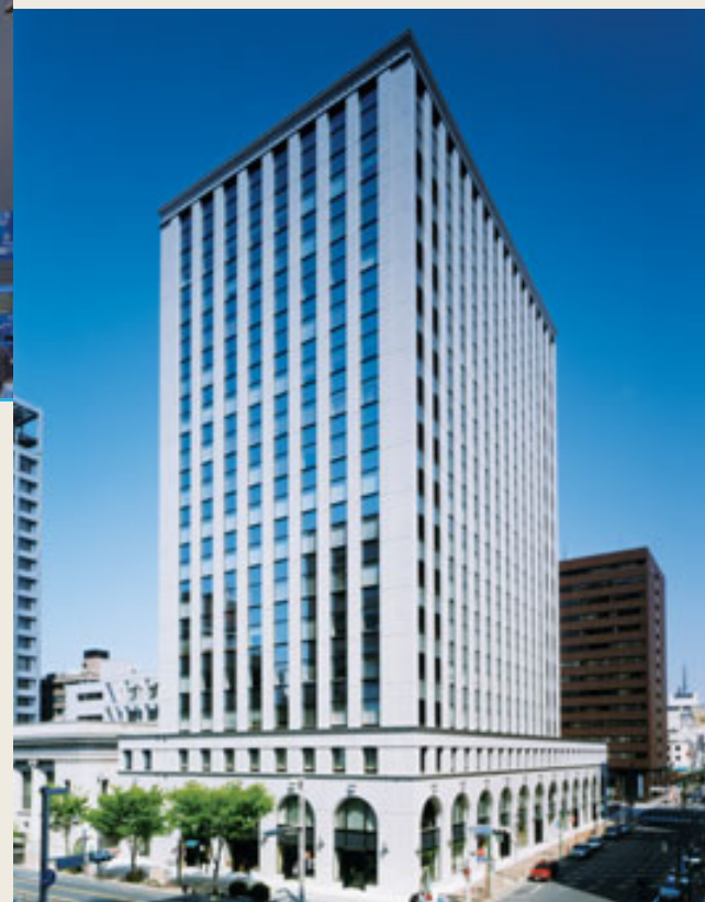
地方都市部 三井住友銀行名古屋ビル
