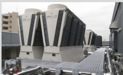
NBF高輪ビル
