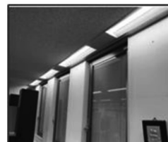
住友電設ビル 専有部
