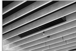
【高性能空気清浄機の設置】
