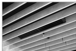
【高性能空気清浄機の設置】
