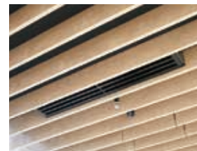
高性能空気清浄機の設置
