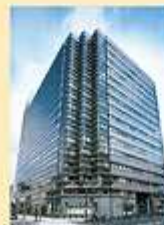
⑮ 新宿本町センタービル
